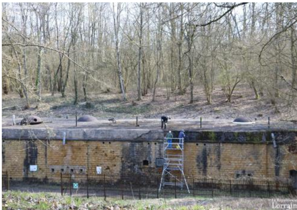
Des travaux d'étanchéité sont menés. Photo RL
